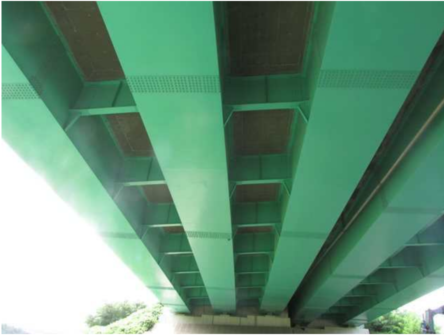
바닥판하면 및 강박스 외부전경
